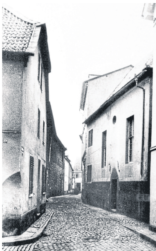
Vorne rechts: die Synagoge in den 1930er Jahren.
