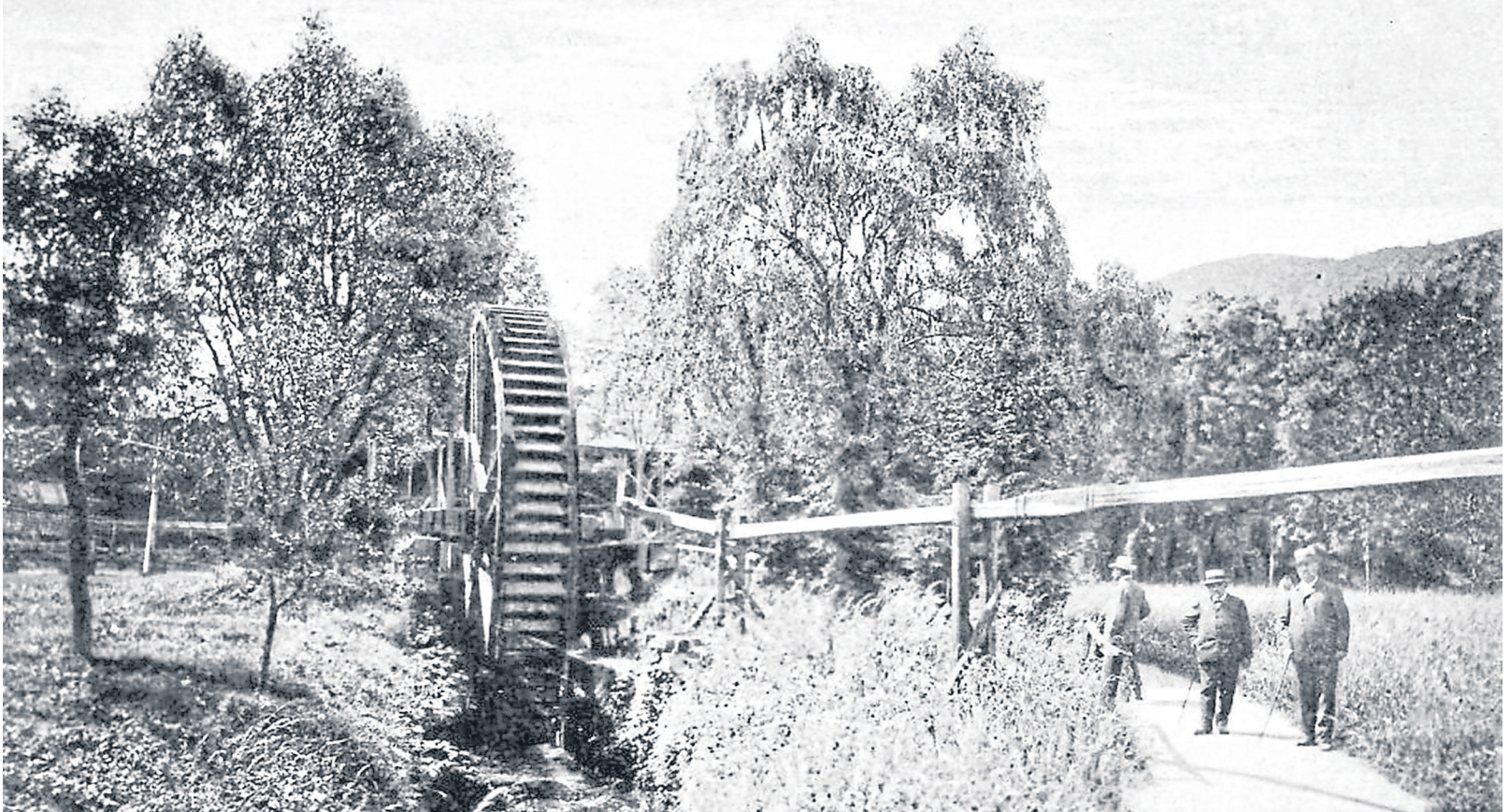
Wasserrad und Pumpengestänge an der Theodorshalle.
