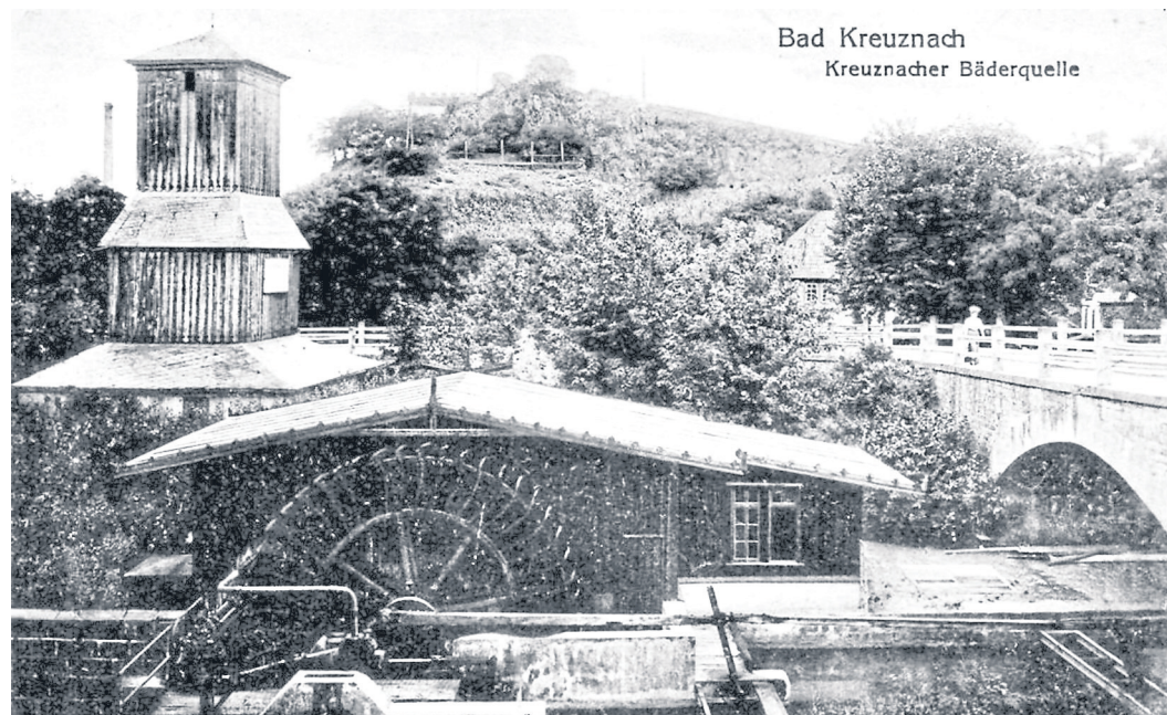
Das Karlshaller Wasserrad vor dem Maschinenhaus, im Hintergrund der hölzerne Pumpenturm.
