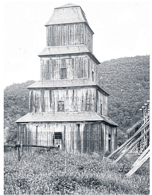
Sole-Pumpenturm der Hauptquelle der Theodorshalle.
