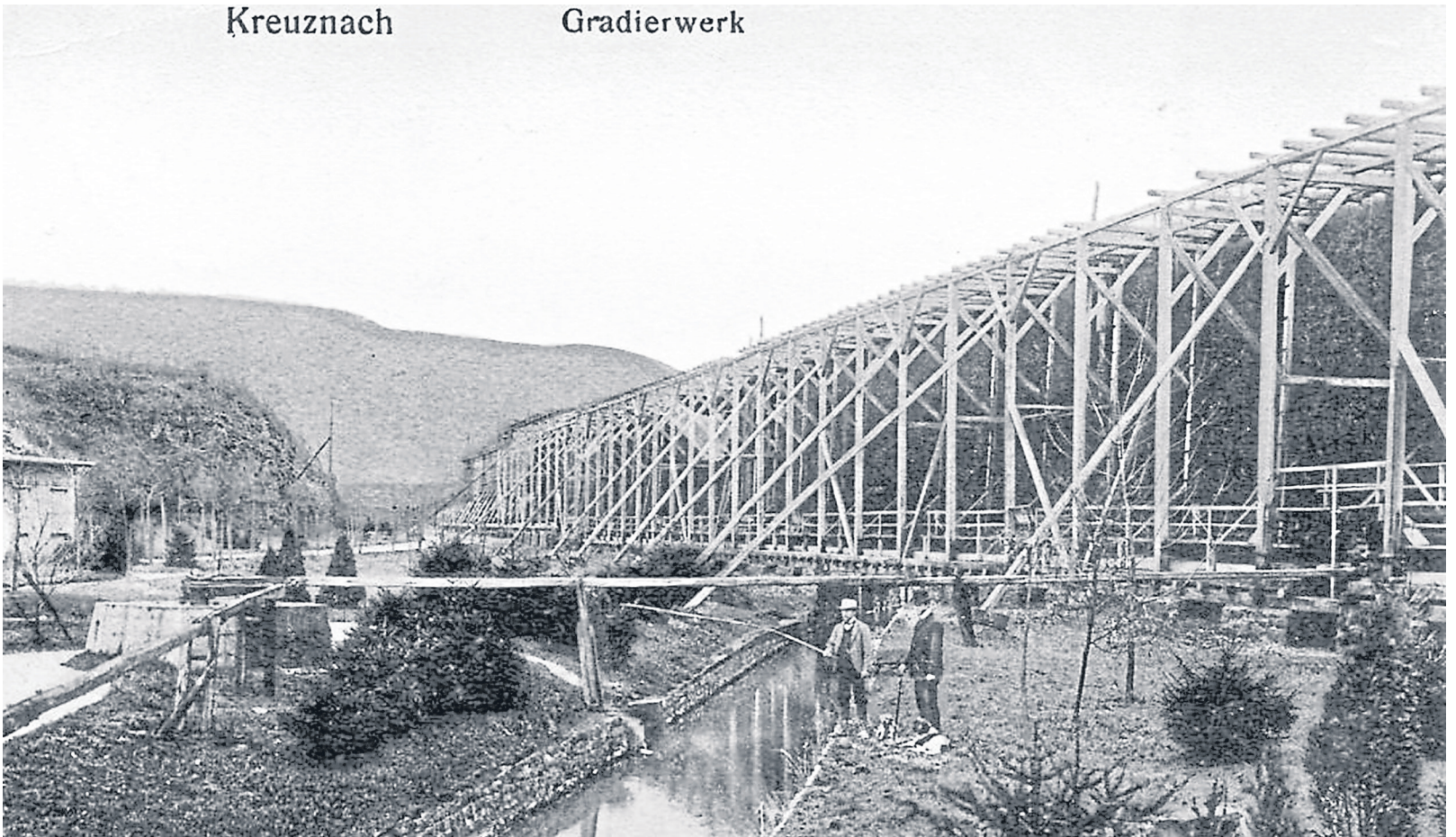
Pumpengestänge und Kunstkreuz beim Karlshaller Gradierhaus um 1910.
