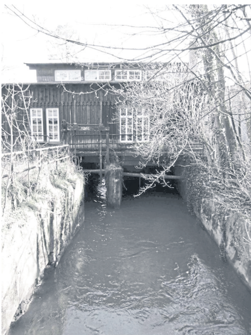
Auslauf des Triebwerkskanals unterhalb des Karlshaller Maschinenhauses.
